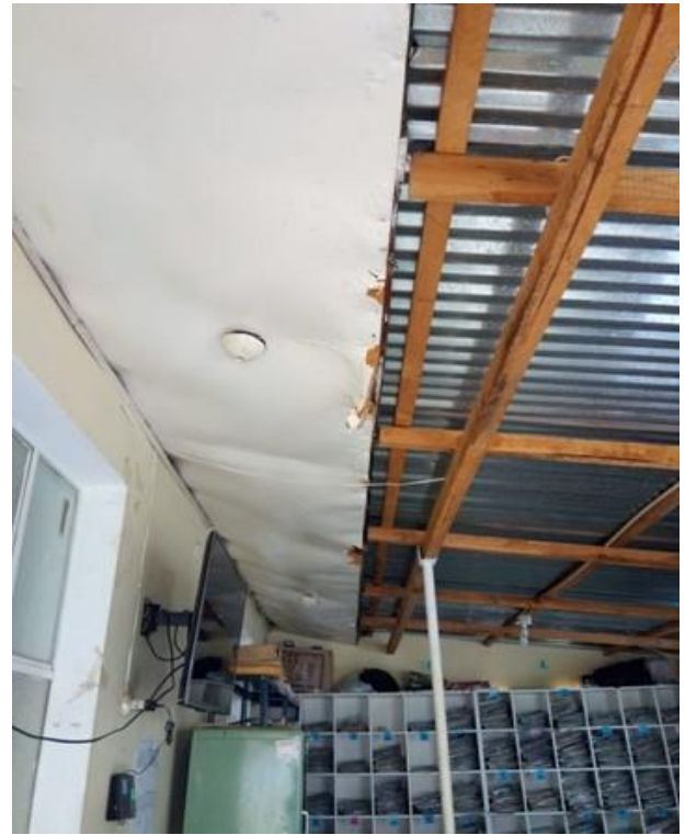
Cielo raso con filtraciones y de las lluvias de ayer noche en distrito
