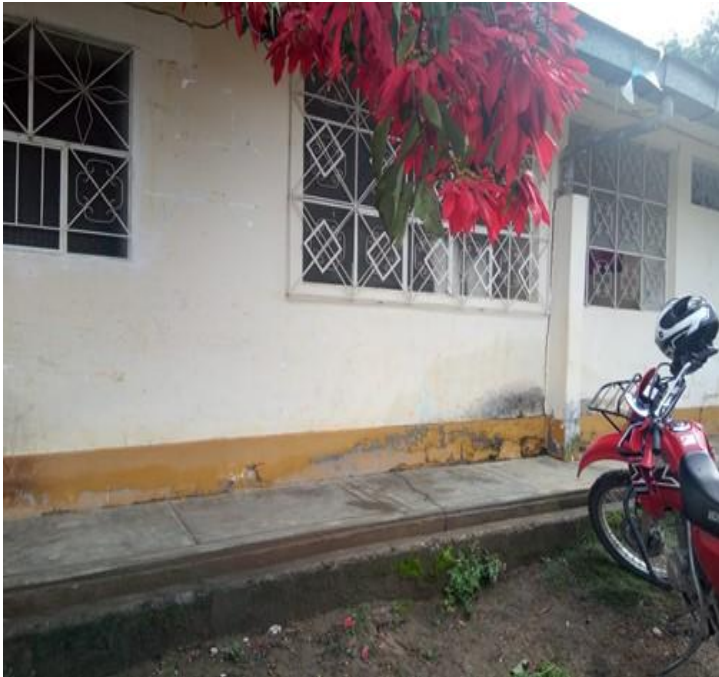
Filtraciones parte externa del centro salud y la otra imagen muestra afectación de cunetas aéreas con afectación de pared del centro salud.
