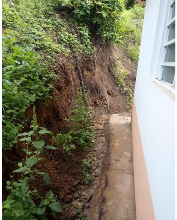
Parte posterior con deslizamientos y laterales que afectan las paredes del modulo
