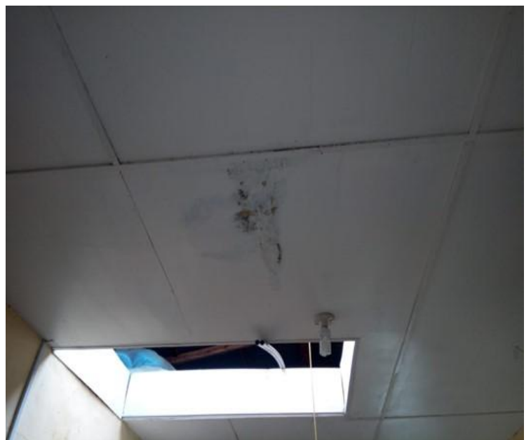
Filtración en techo de componente niño, cielo raso con muestras de agua humedecida
