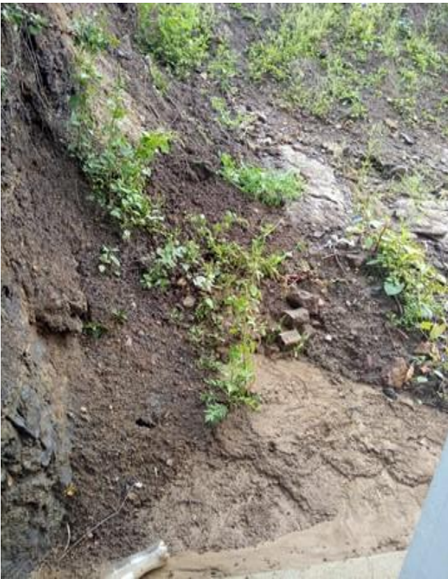
Parte posterior con deslizamientos y laterales que afectan las paredes del modulo
