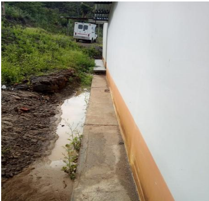
Cuneta del módulo parte posterior y lateral que presenta caída con barro y las aguas de partes altas que escurre
