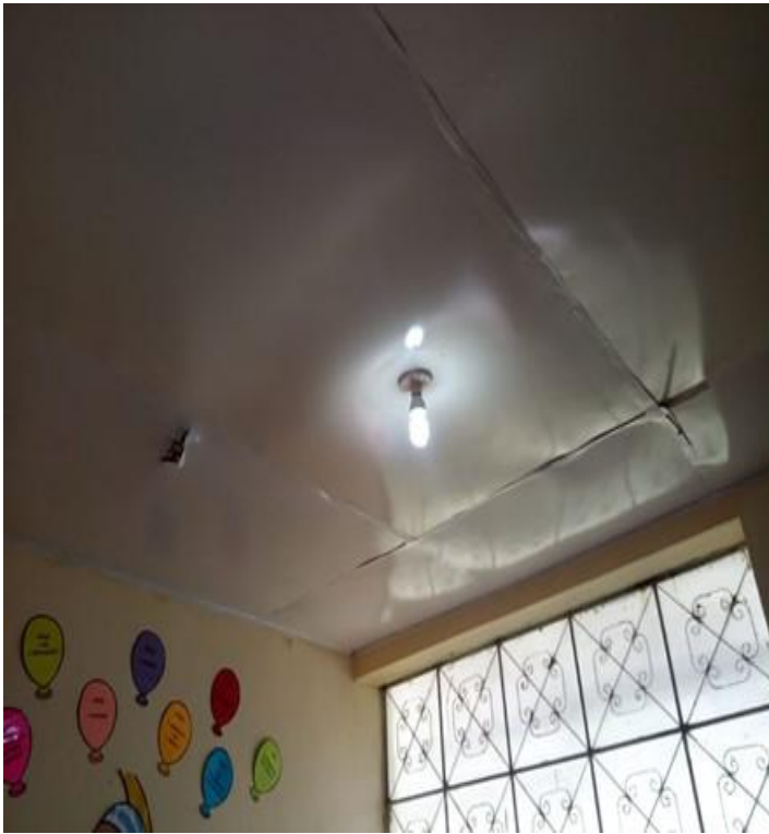
Cielo raso con filtraciones y de las lluvias de ayer noche en distrito
