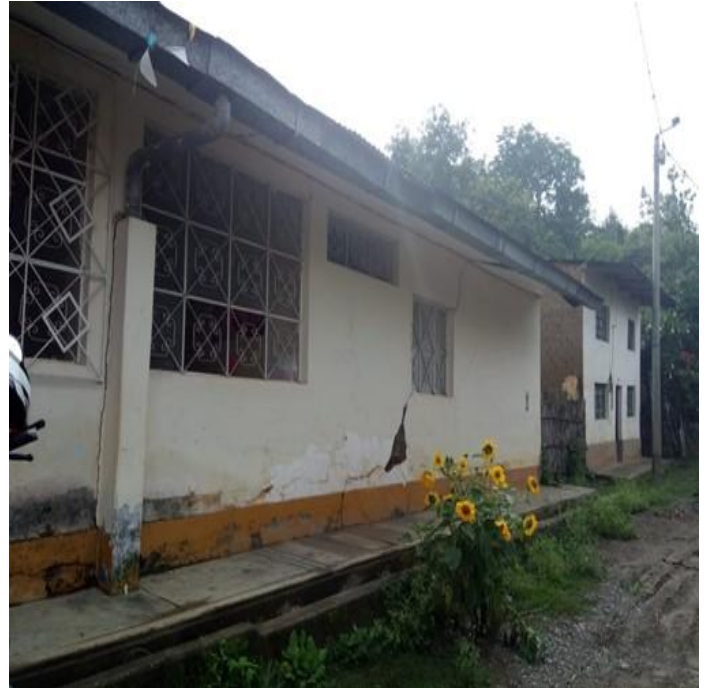
Filtraciones parte externa del centro salud y la otra imagen muestra afectación de cunetas aéreas con afectación de pared del centro salud.
