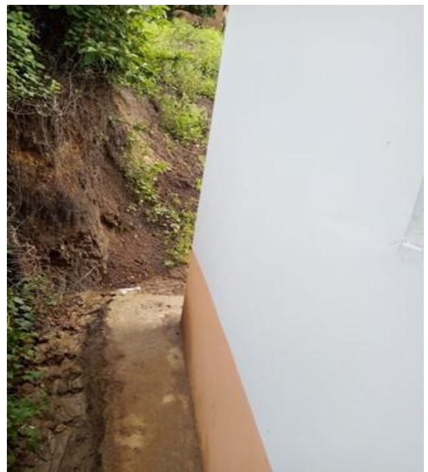
Cuneta del módulo parte posterior y lateral que presenta caída con barro y las aguas de partes altas que escurre
