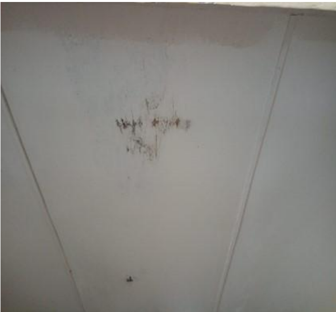
Filtración en techo de componente niño, cielo raso con muestras de agua humedecida
